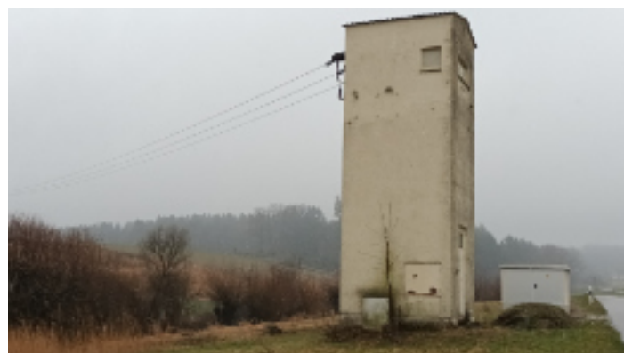
Bild: Das alte Transformatorhaus in Bachling links, wird ersetzt durch den neuen leistungsfähigeren Trafo rechts.
